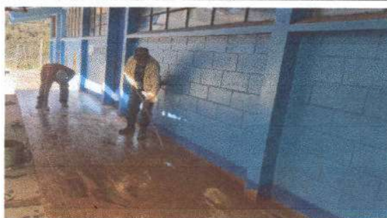
Foto 5: Sustrucción de piso de cemento líquido por piso cerámico en Corredor Módulo I
