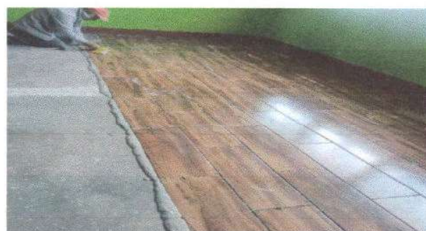
Foto 3: Sustrucción de piso de cemento líquido por piso cerámico en aula Módulo I
