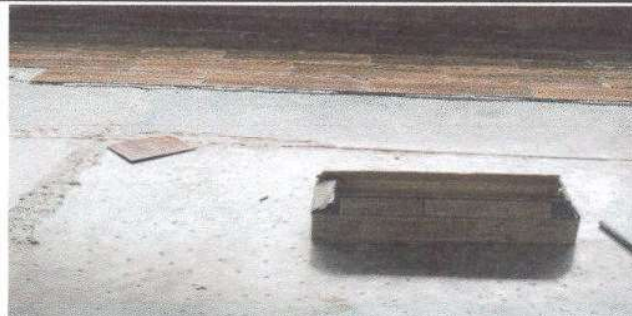
Foto 6: Sustrucción de piso de cemento líquido por piso cerámico en Cocina
