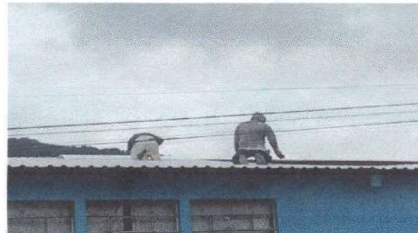
Foto 2: Sustrucción de lámina, por lámina troquelada aluzinc calibre 26 Módulo I
